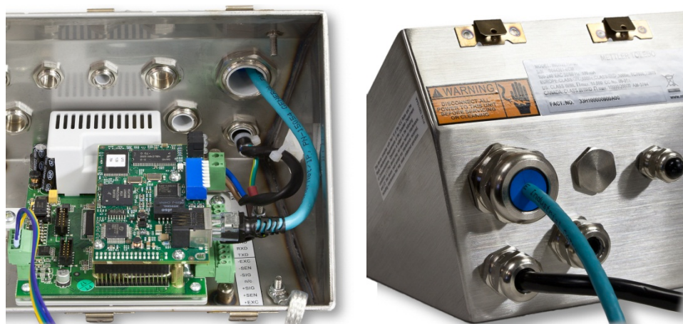
Figura 2-66: Colocación del cable Ethernet en el gabinete para ambientes adversos
