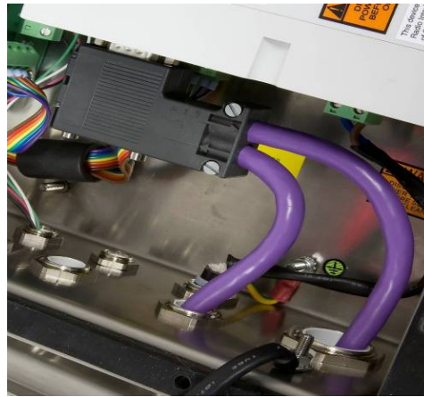
Figura 2-70: Colocación del cable PROFIBUS en el gabinete para caja de conexiones, versión original
