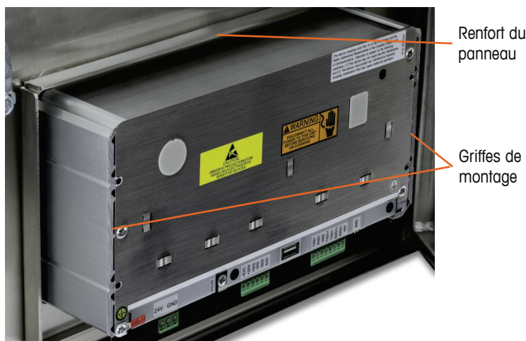
Figure 2-6: Renfort du panneau installé
