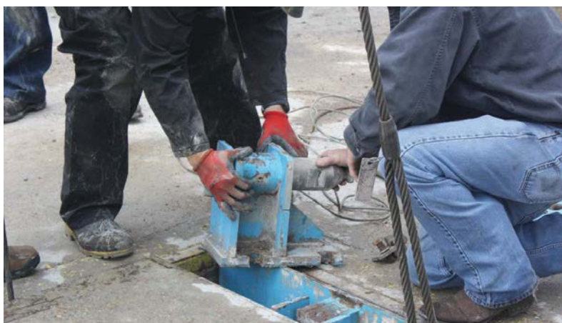
La sustitución de las células de carga que fallan puede ser una exigencia continua que acabe costando más de lo que cuesta la báscula entera.
