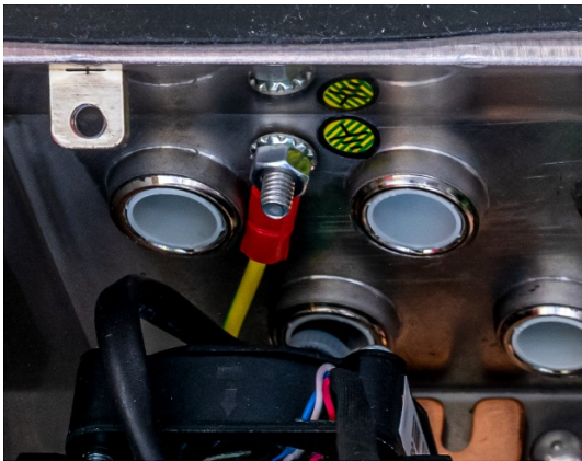
Fig. 35: Perno de conexión a tierra, carcasa para entornos difíciles
