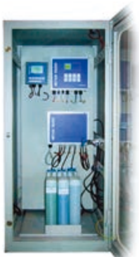
金川集团的自动化清洗和校准系统
