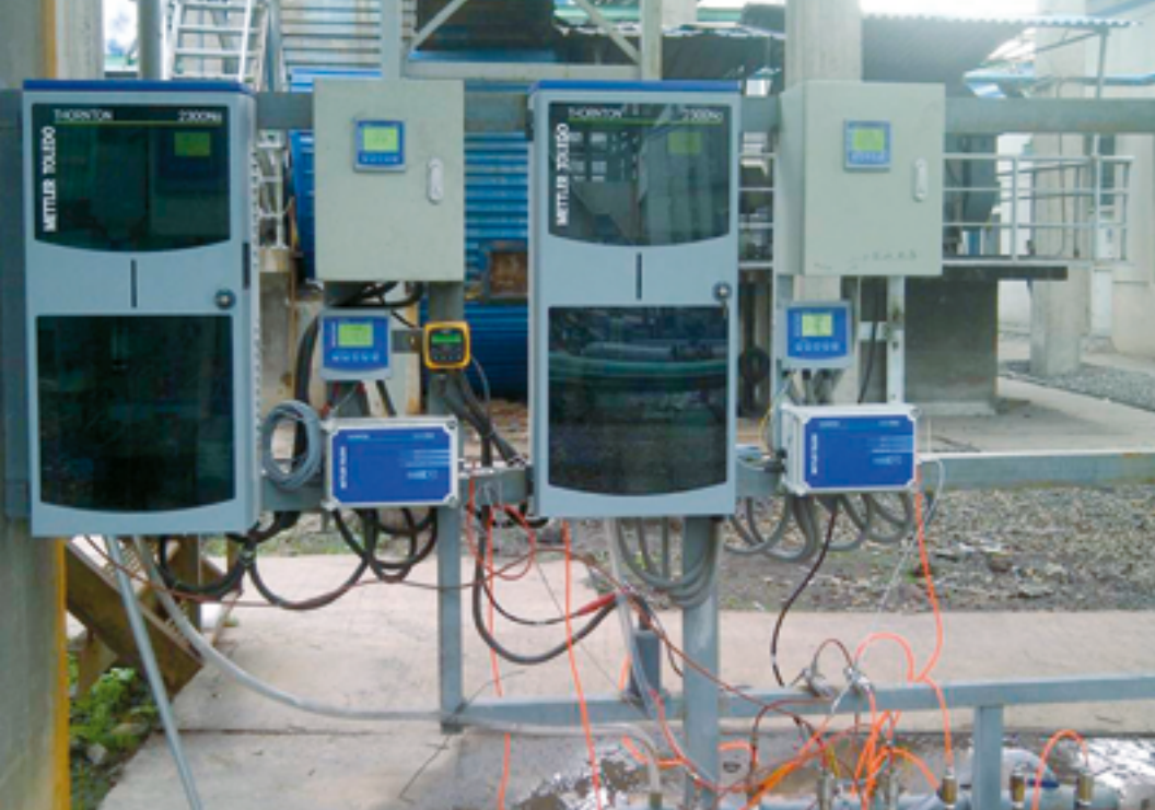
Systeme zur Kondensatrückführung von METTLER TOLEDO mit den 2300Na Natrium-Analyser, welche bei Jiahua Energy stehen.
