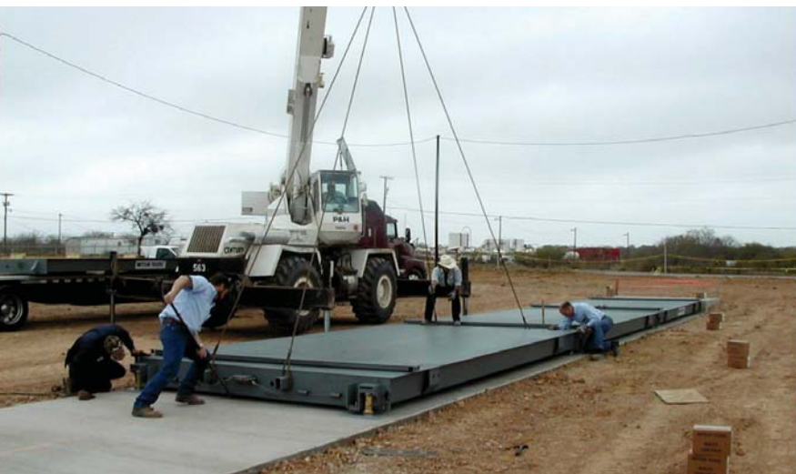
正在安装钢结构秤台
