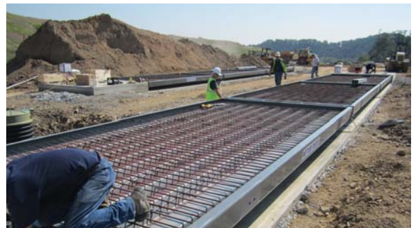
这台汽车衡已准备好等待混凝土的浇灌。
