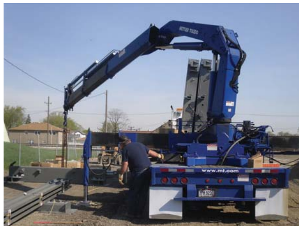
在一个夯实的土地上组装一台可移动式汽车衡
