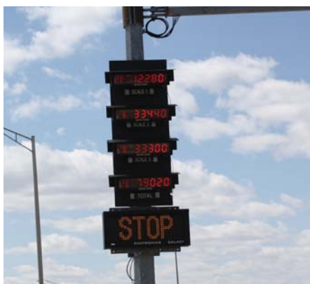
公路收费站采用多个显示器告诉司机汽车每轴组的重量以及汽车的总重。
