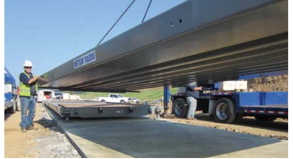
汽车衡模块就位基础上。
