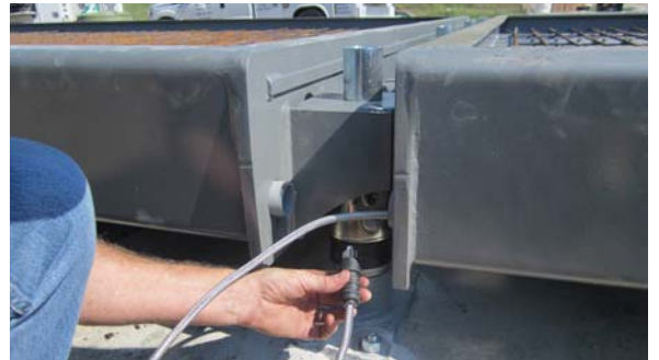
穿传感器电缆并连接到传感器上。
