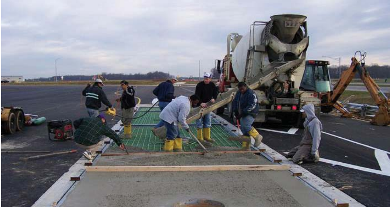
混凝土现场浇注
