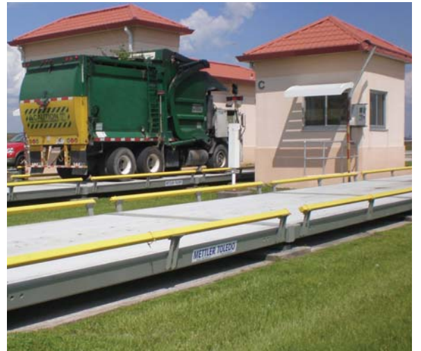
汽车衡磅房可以有多种用途,包括汽车衡运转、称重处理以及现场安保
