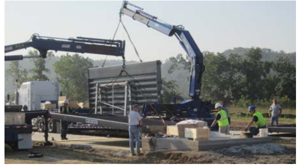
这些卡车配备了车载吊机, 用来起吊汽车衡模块, 并将其放在基础上。
