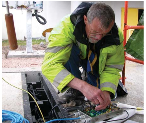
技术员正在测试接线盒内的传感器电缆线的连接。
