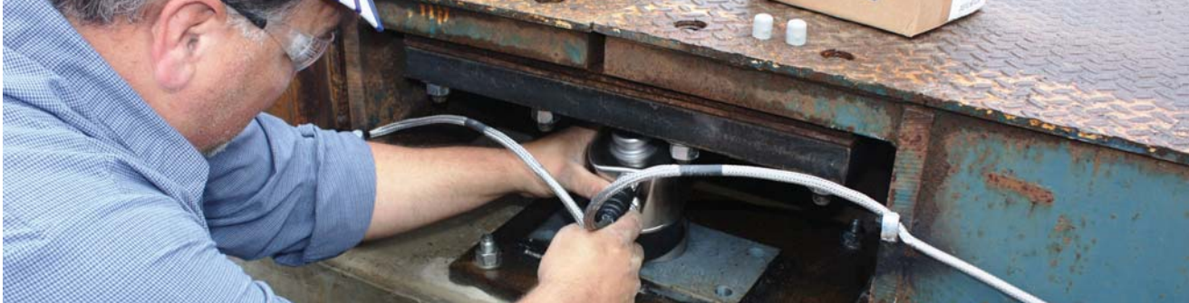
升级改造现有的地磅，通过安装全新的称重传感器系统来提高秤台的精度和可靠性
