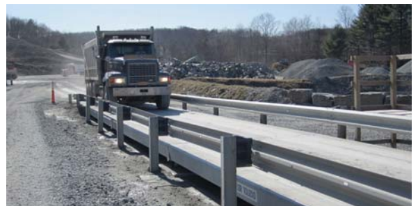
沿着汽车衡在地面上单独建立的护栏能提供卓越的保护性能,防止汽车驶出汽车衡的边缘。
