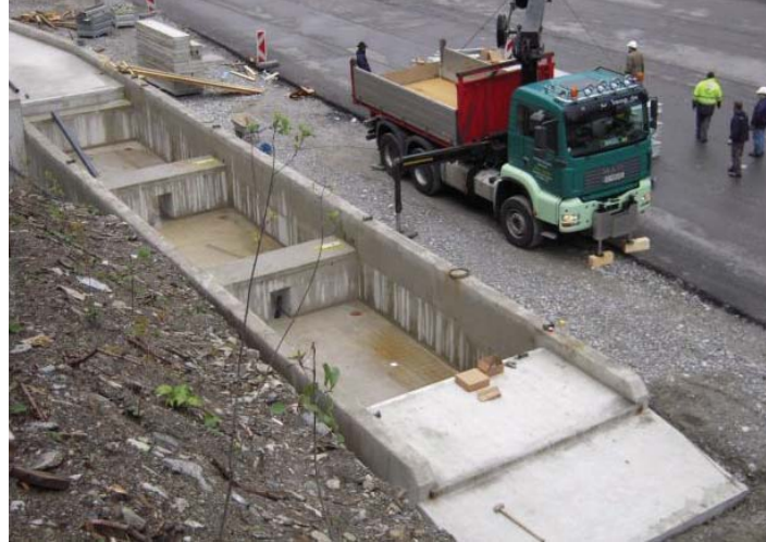
汽车衡基础应当包括适当的引道，引道应符合当地法规
