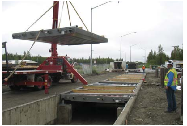
一台有基坑类型的汽车衡放置到已挖掘的基础中, 与地面齐平
