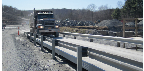
รางนำทางแบบติดตั้งบนฐานรากเหล่านี้ถูกติดตั้งลงในพื้นที่ดินควบคู่ไปกับแนวเครื่องชั่ง เพื่อเพิ่มความแข็งแรงและป้องกันไม่ให้รถบรรทุกขับตกด้านข้างของเครื่องชั่ง
