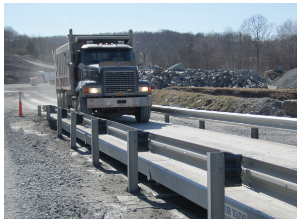
ตัวอย่าง ไซต์หินก่อสร้าง อาจเห็นว่าเครื่องชั่งแบบเปิดด้านข้างสามารถทำความสะอาดเศษหินที่หกหล่นออกมาได้โดยง่าย
