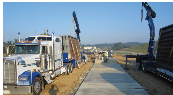
รถบรรทุกจัดส่งที่ออกแบบมาเป็นพิเศษสามารถขนส่งโมดูลแท่นชั่งในสภาพที่ตั้งขึ้นแล้ว
