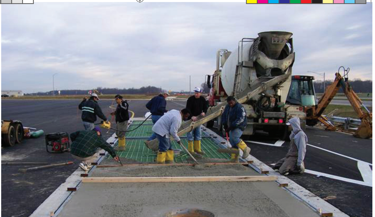
การเทคอนกรีตลงในฐานของแท่นชั่งคอนกรีตในระหว่างการติดตั้ง
