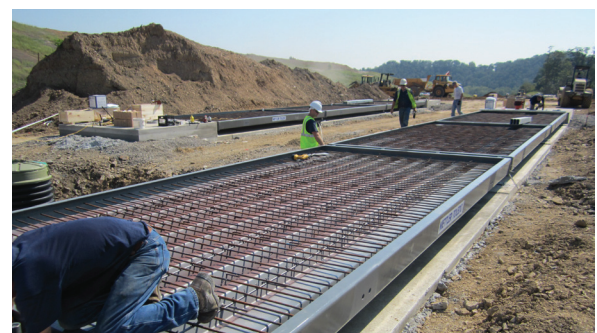
เครื่องชั่งนี้ใกล้จะพร้อมรับการเทคอนกรีตลงบนโมดูลแทนชั่งแล้ว
