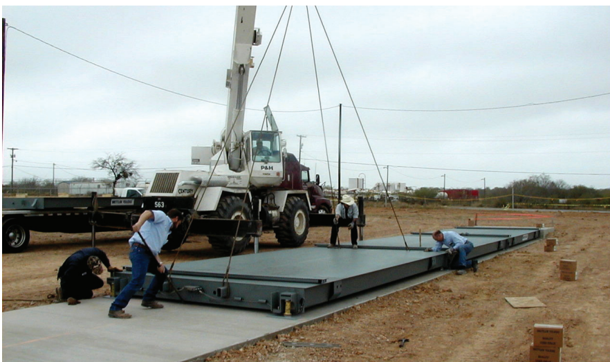
การติดตั้งเครื่องชั่งแบบพื้นผิวเหล็ก
