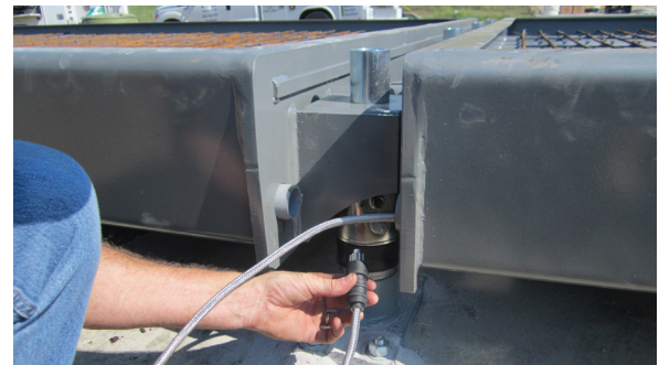
สายเคเบิลของโหลดเซลล์เดินสายผ่านเครื่องชั่งและต่อเข้ากับโหลดเซลล์
