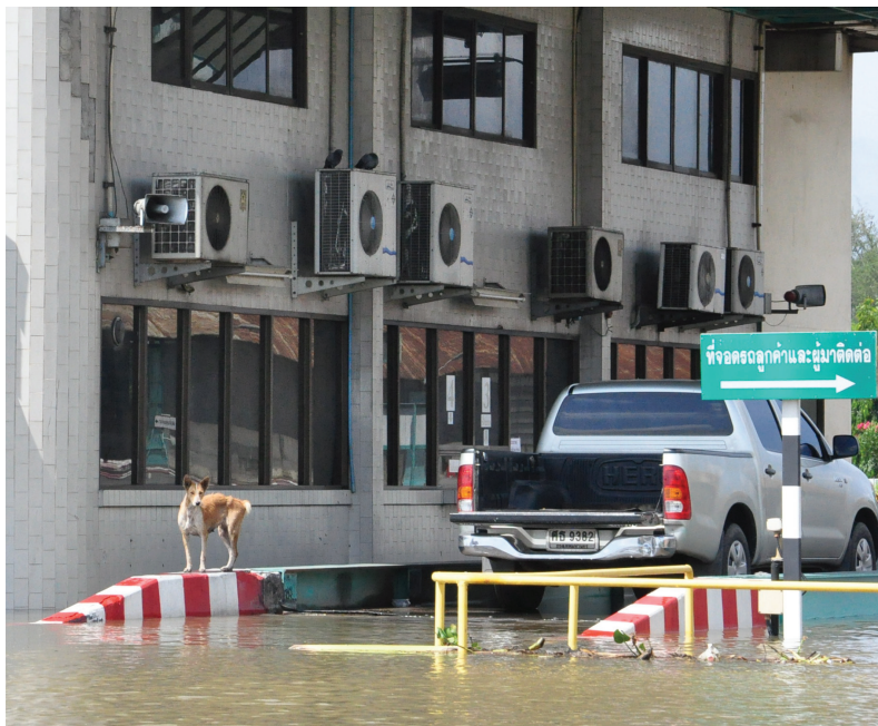
เกิดน้ำท่วมอย่างหนักทำให้เครื่องชั่งรถบรรทุกต้องจมน้ำนานหลายสัปดาห์ที่โรงงานสารเคมีในประเทศไทย แต่เนื่องจากระบบป้องกันน้ำที่ยอดเยี่ยมเมื่อน้ำลดลง ผู้ดำเนินงานถึงกับแปลกใจเมื่อเครื่องชั่งยังคงทำงานได้ตามปกติ
