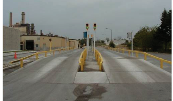
รางนำทางจะมีการติดตั้งไปกับด้านข้างของโมดูลแท่นชั่งโดยมีสลักหรือตัวยึดเชื่อม
