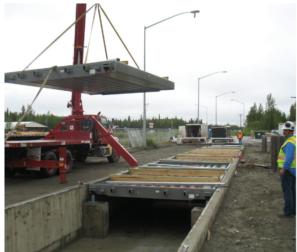
ส่วนเครื่องชั่งแบบหลุมถูกจัดวางในฐานติดตั้งที่ขุดหลุมลงไป จนอยู่ในระนาบเดียวกับพื้นดิน
