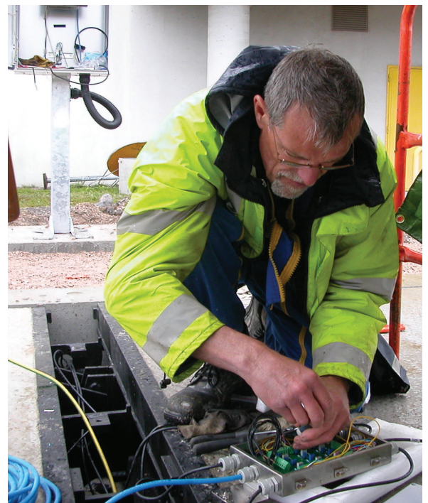
ช่างเทคนิคทดสอบสายเคเบิลเชื่อมต่อของโหนดเซลล์ภายในกล่องรวมสัญญาณ
