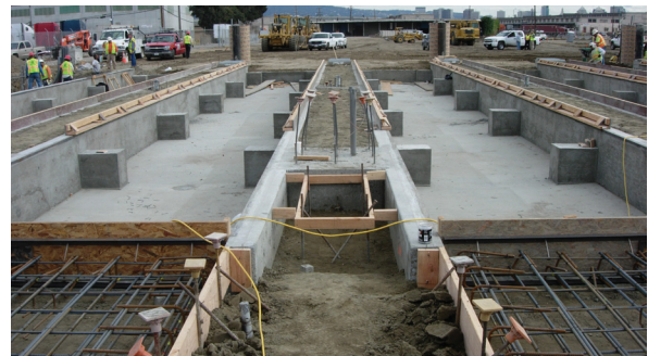
การจัดเตรียมฐานติดตั้งอาจดำเนินการก่อนที่ส่วนประกอบของเครื่องชั่งจะไปถึงไซต์งาน
