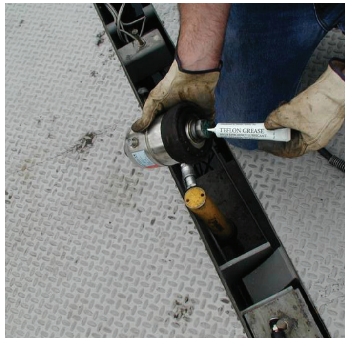
ในบางพื้นที่ เช่น พื้นผิวสัมผัสของโหลดเซลล์ ต้องใช้สารหล่อลื่นตามกำหนดเวลา
