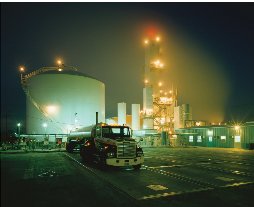
พื้นที่ในโรงงานด้านปิโตรเคมีมักจะถูกจัดเป็นพื้นที่อันตราย ซึ่งหมายความว่าเครื่องชั่งรถบรรทุกและส่วนประกอบต่าง ๆ จะต้องสอดคล้องกับข้อกำหนดเฉพาะด้านความปลอดภัยที่เพิ่มเติมเข้ามา
