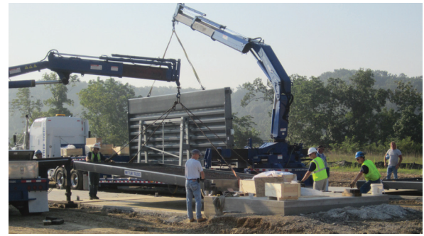
รถบรรทุกจัดส่งเครื่องชั่งเหล่านี้ติดตั้งเครนบนรถ ซึ่งใช้เพื่อยกและวางโมดูลแทนชั่งลงในฐานรากเครื่องชั่ง
