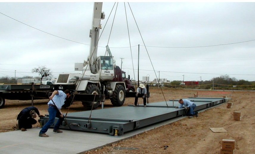
鋼鉄製デッキのウェイブリッジの設置
