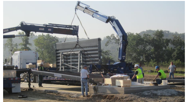
このようなスケール配送トラックには、ウェイブリッジモジュールを持ち上げて、スケールの基礎に設置するために使用する車載クレーンが搭載されています
