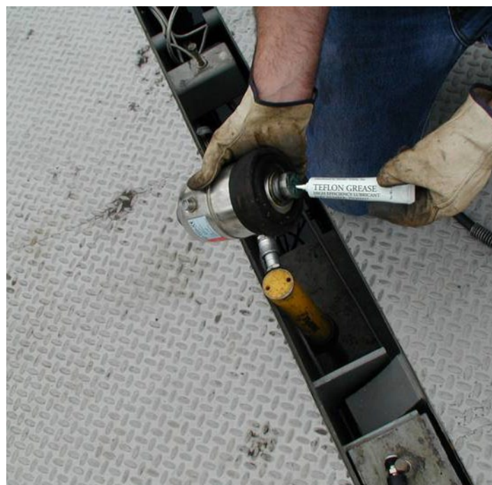
ロードセルの合わせ面などの一部の場所では、定期的に潤滑する必要がある
