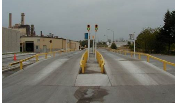
スケールマウントガイドレールはウェイブリッジのサイドにボルトまたは溶接ブラケットで取り付けられています
