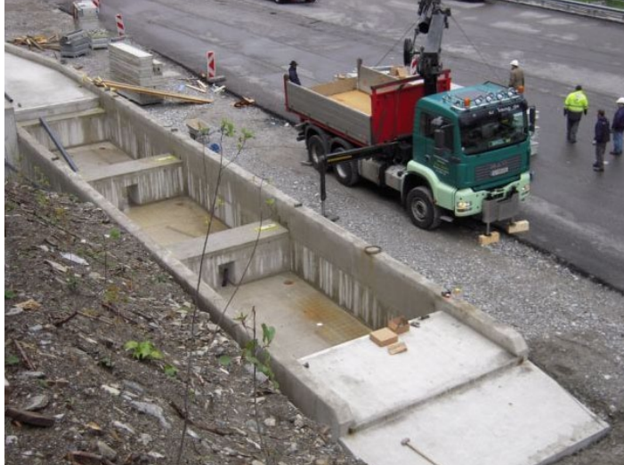
スケールの基礎には、地域の規制に従った適切なアプローチが必要
