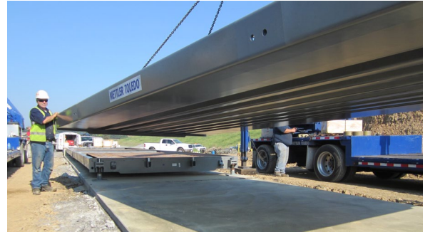
ウェイブリッジモジュールは基礎に置かれます
