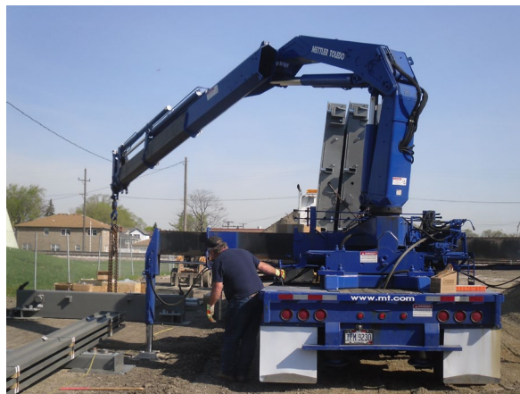
コンパクションで固めて準備した土壌サイトに、ポータブルフレームのトラックスケールを設置します
