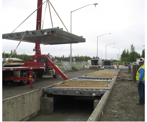
ピットスケールを掘削した基礎に地面と面一になるように置いています
