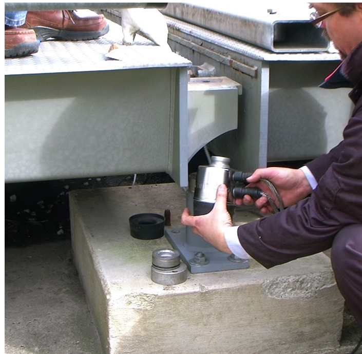
ロードセル、レシーバー、その他の重要部品の摩耗を定期的にチェックする
