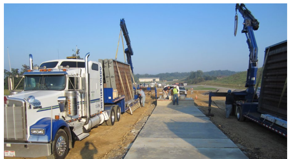
特別に設計された配送トラックでウェイブリッジを立てた状態で搬送することができます
