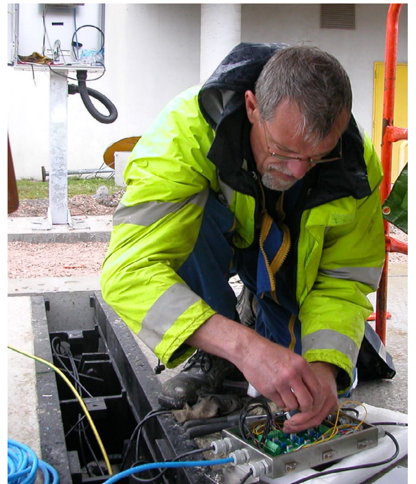
技術者が和算箱内のロードセルケーブルの接続を点検します
