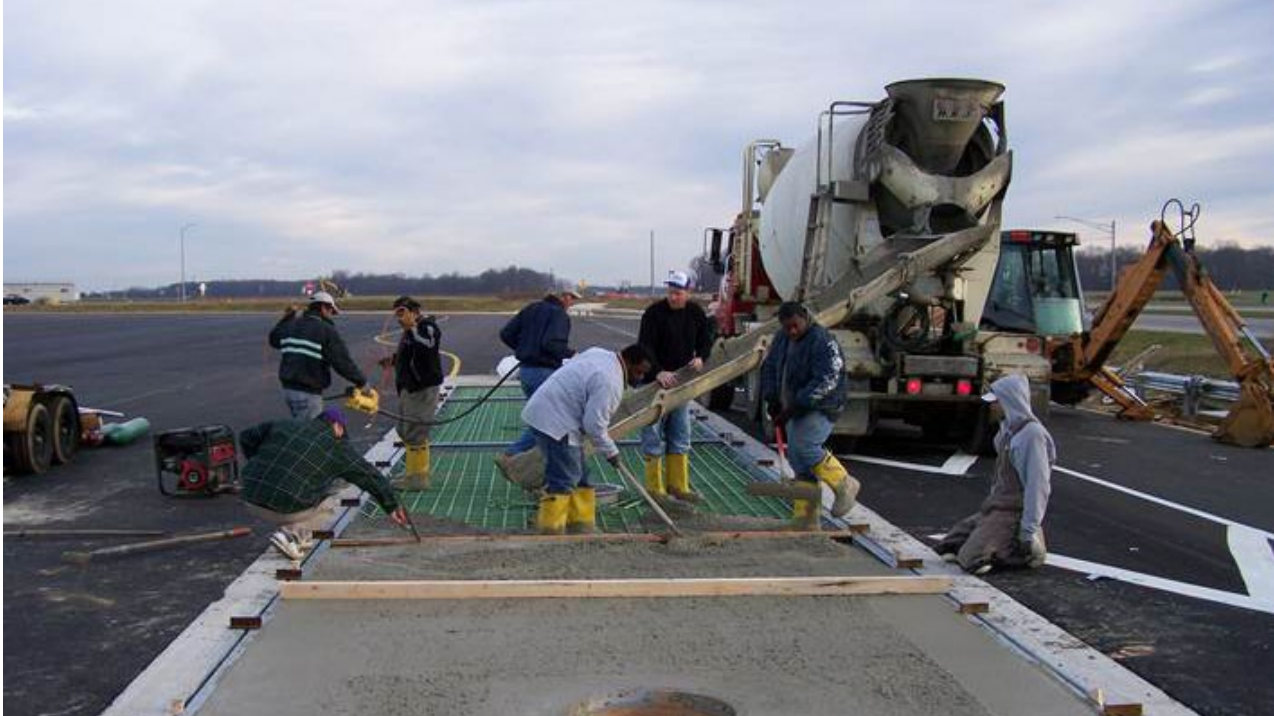
コンクリート製ウェーブブリッジの設置時にコンクリートを打ち込んでいます
