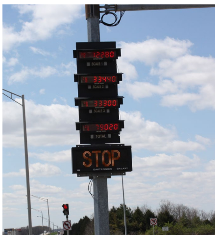
道路計量ステーションは複数のリモートディスプレイを使用して、運転手に各デュアルタンデムアクスルの重量、およびトラックの総重量を表示します
