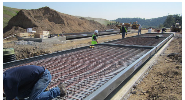
このスケールはコンクリートをデッキモジュールに打ち込む準備がほとんどできています
