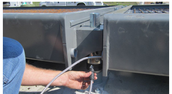
ロードセルケーブルはスケールを通して配線し、ロードセルに接続
