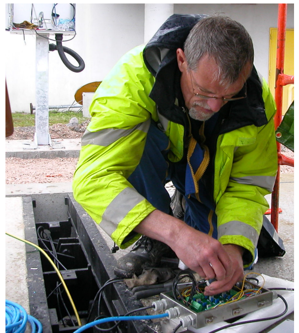
Un técnico prueba las conexiones de cables de celdas de carga dentro de una caja de conexiones
