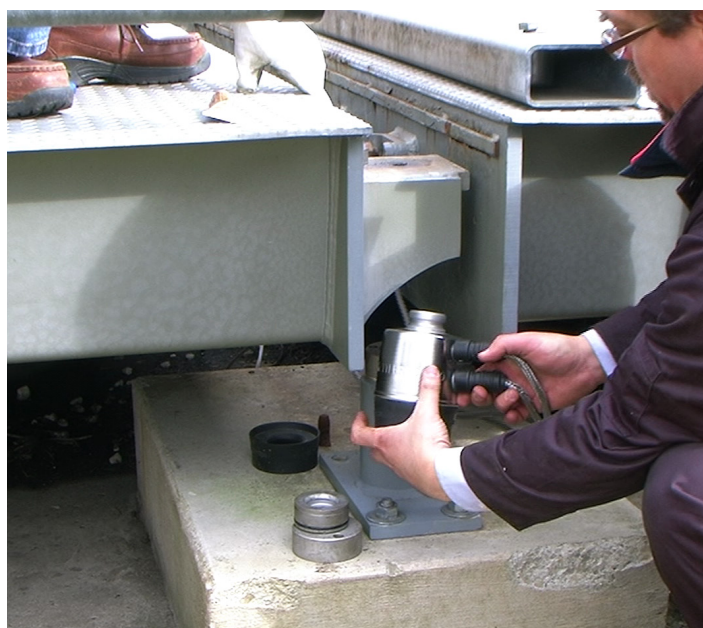
Se deben revisar las celdas de carga, receptores y otras piezas fundamentales para verificar si presentan desgaste
