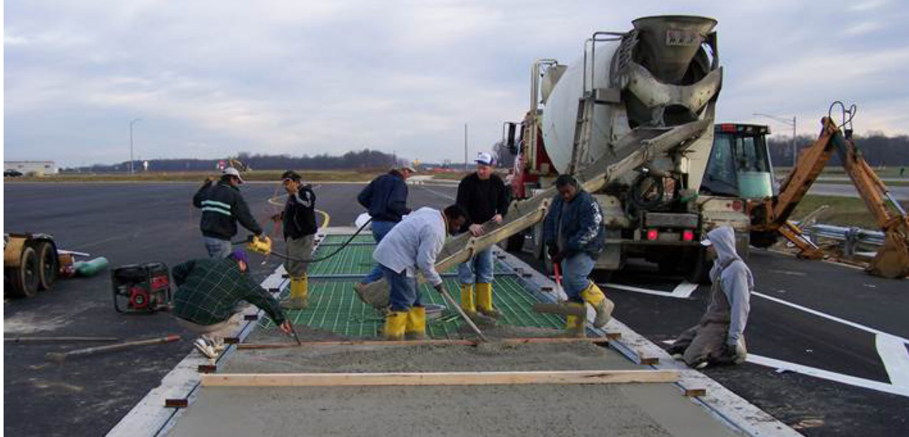
Se echa hormigón en la plataforma de una plataforma de pesaje de hormigón en la instalación
