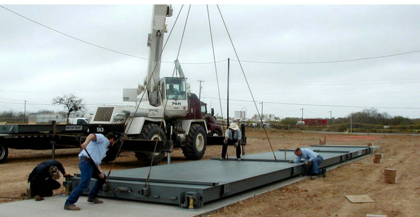
Se instala una plataforma de pesaje de acero
