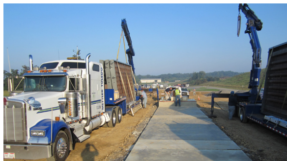
Camiones de entrega especialmente diseñados transportan los módulos de la plataforma de pesaje en posición erguida
