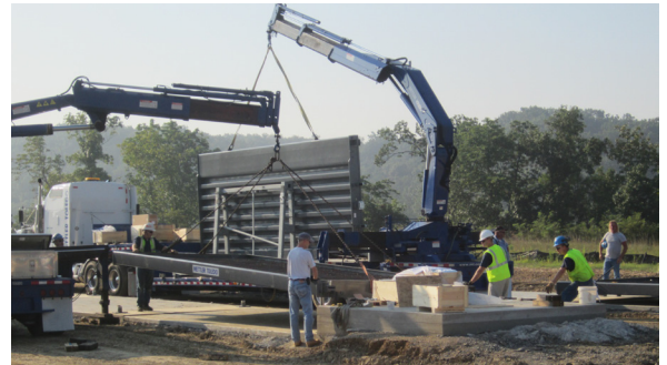
Estos camiones de entrega de básculas están equipados con grúas incorporadas que se usan para izar y colocar los módulos de la plataforma de pesaje en la cimentación de la báscula
