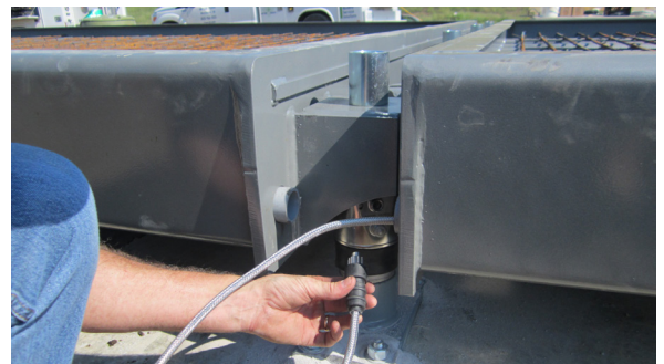
Se tienden los cables de las celdas de carga a través de la báscula y se los conecta a las celdas de carga
