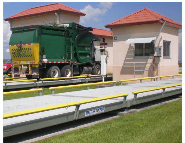
Una casilla de pesaje puede servir para varios fines, entre ellos la operación de la báscula, el desarrollo de transacciones y vigilancia del sitio
