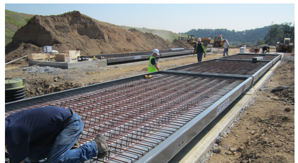
Esta báscula está casi lista para verter el hormigón en los módulos de la plataforma
