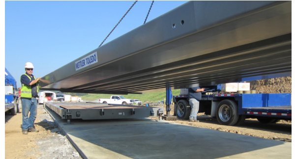
Los módulos de la plataforma de pesaje se colocan en la cimentación
