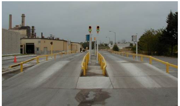
Se colocan barandales montados sobre la báscula al costado de la plataforma de pesaje con pernos o abrazaderas soldadas
