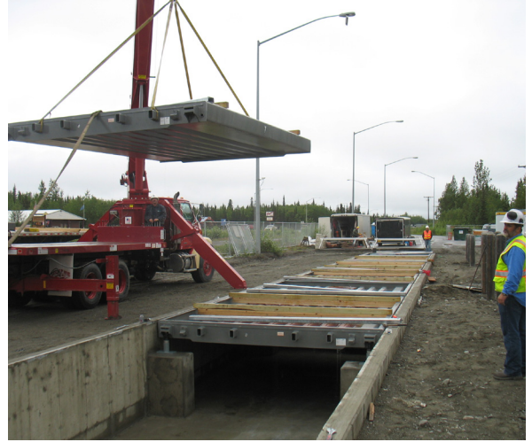
Una báscula de pozo se coloca en una cimentación excavada, al ras de piso
