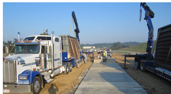
Spezial-Lkws können die Wägebrückenmodule in aufrechter Position anliefern
