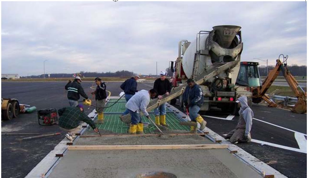
Der Boden einer Betonwägebrücke wird bei der Installation mit Beton gefüllt
