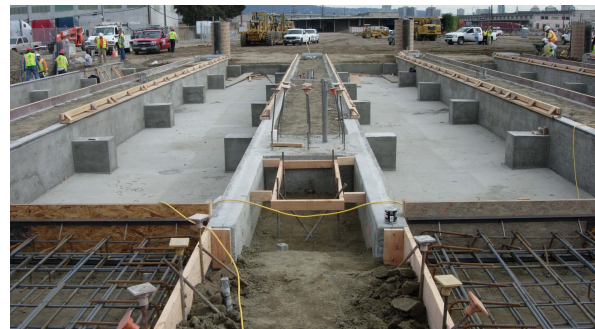
Die Fundamentvorbereitung kann vor dem Eintreffen der Waagenkomponenten erfolgen.
