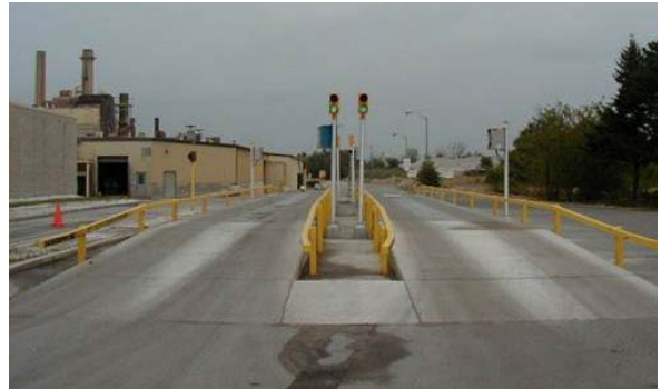
Geländer werden mit Bolzen oder geschweissten Halterungen an der Seite der Wägebrückenmodule montiert
