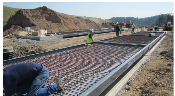
Die Bodenmodule dieser Waage können bald mit Beton gefüllt werden
