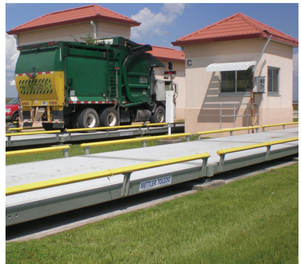
Ein Waagengebäude kann mehrere Aufgaben erfüllen und zur Waagenbedienung, Transaktionsverarbeitung und als Schutzraum dienen
