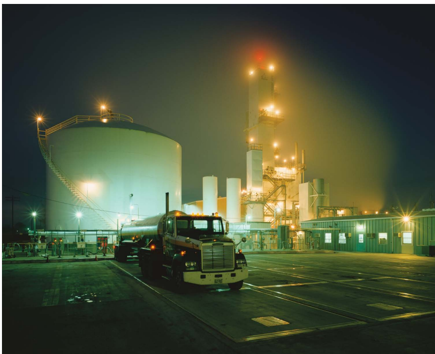
Petrochemische Anlagen sind oft als Ex-Bereiche klassifiziert, das heißt, Lkw-Waagen und ihre Komponenten müssen in diesen Bereichen zusätzliche Sicherheitsanforderungen erfüllen
