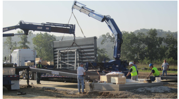
Diese Lkws für die Waagenanlieferung sind mit eigenen Krananlagen ausgestattet, um die Wägebrückenmodule anzuheben und in das Waagenfundament einzusetzen
