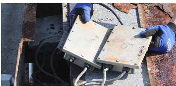
Anschlusskästen enthalten Platinen und zahlreiche manuelle Kabelverbindungen. Sie sind die Hauptursache für Ausfallzeiten von Lkw-Waagen, weil es schwierig ist, sie gegen Feuchtigkeit abzudichten.
