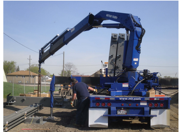
Zusammensetzen des Rahmens einer mobilen Lkw-Waage auf einem zuvor verdichteten Erdfundament
