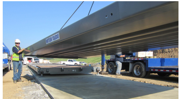
Die Wägebrückenmodule werden in das Fundament eingesetzt
