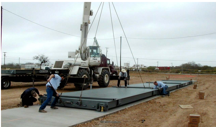
Installation einer Wägebrücke mit Stahlboden
