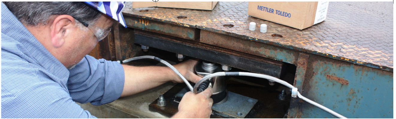
Durch die Aufrüstung einer vorhandenen Wägebrücke mit einem neuen Wägezellensystem können Sie die Genauigkeit und Zuverlässigkeit der Waage verbessern
