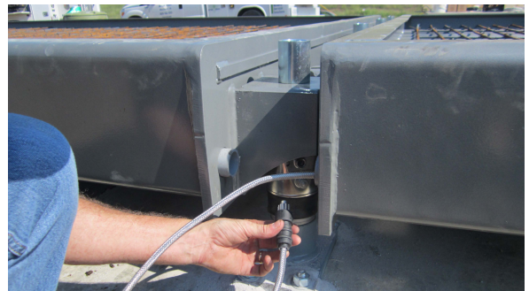
Wägezellenkabel werden durch die Waage geführt und mit den Wägezellen verbunden
