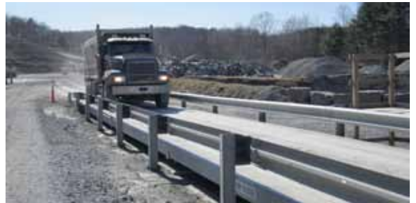
이런 독립형 가이드레일은 스케일 옆의 지면에 설치되어 부가적인 강도를 제공하고 트럭이 스케일 가장자리로 이동하지 않도록 예방합니다.
