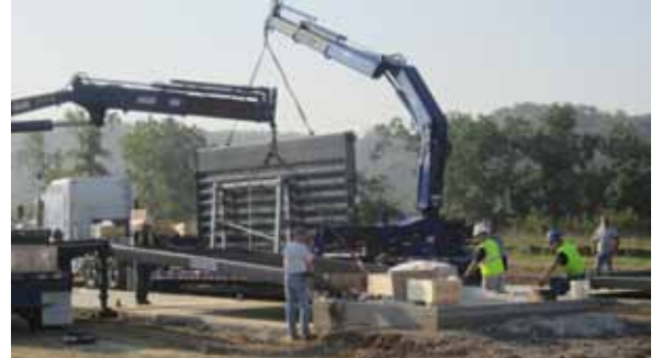
이런 스케일 납품 트럭에는 계량대 모듈을 스케일 기반에 들어 올려 배치하는 데 사용되는 내장 크레인이 장착되어 있음
