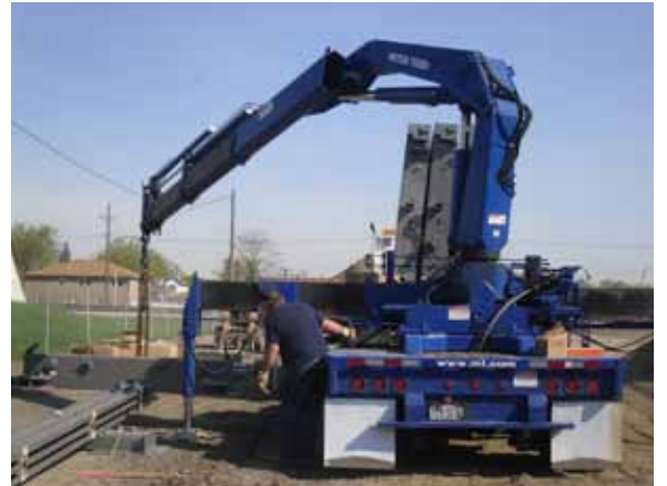
준비된 잘 다져진 토양 현장에서 휴대용 프레임 트럭 스케일 조립하기
