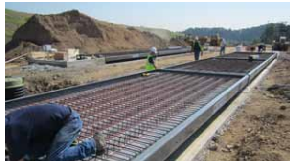
이 스케일은 콘크리트가 데크 모듈에 주입됨으로 인해 거의 준비됨
