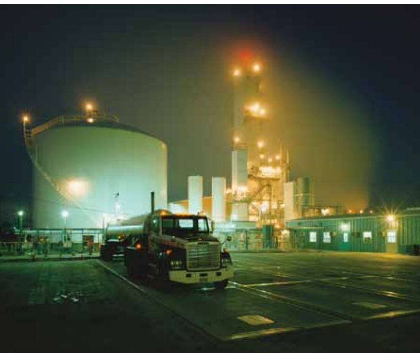
석유화학 시설은 종종 방폭 지역으로 분류되는데 이는 트럭 스케일 및 구성품이 추가된 안전 규격을 준수해야 함을 의미합니다.
