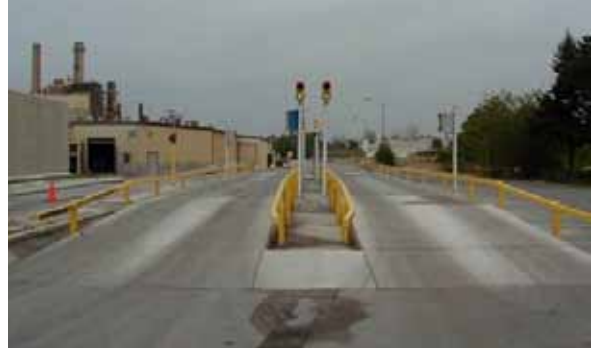
스케일 장착형 가이드레일은 볼트 및 용접된 브래킷과 함께 계량대 모듈의 측면에 장착됩니다.
