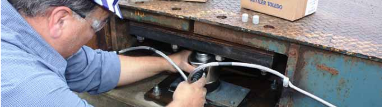
새로운 로드 셀 시스템을 설치함으로써 기존 계량대를 업그레이드해 스케일의 정확도 및 신뢰성 개선
