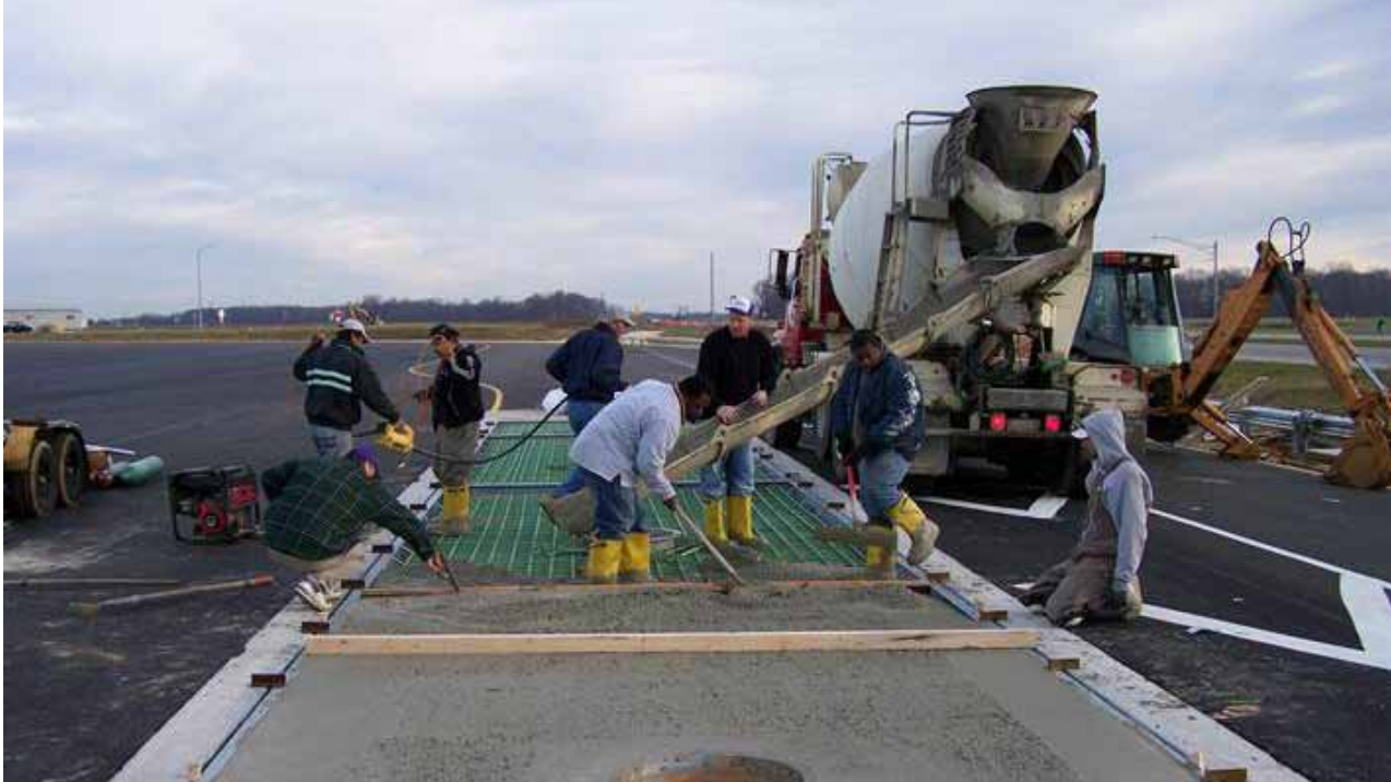
설치 단계에서 콘크리트 계량대의 데크에 콘크리트가 주입됨
