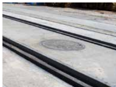
Tablier en béton
